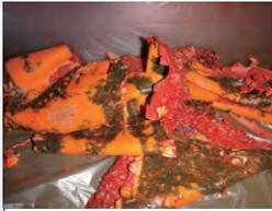
はく離した塗膜は湿潤シート状態で回収できます。塗膜に含有する有害物質の飛散、拡散が低減できます。
