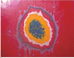
既存塗膜厚測定、塗膜構成、塗替え回数を確認します。
