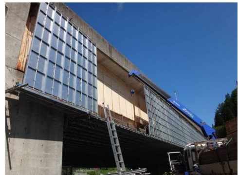
写真①：水系塗膜剥離剤工法施工時の足場例
