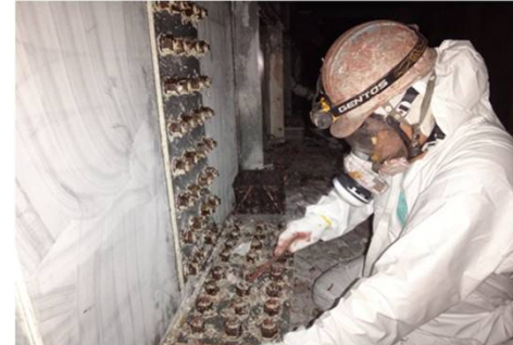
有害物質含有既存塗膜 掻き落とし作業状況③ 電動ファン付き呼吸用保護具装着
