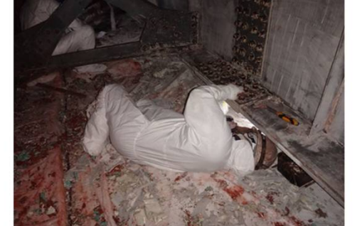
有害物質含有既存塗膜 掻き落とし作業状況④ 電動ファン付き呼吸用保護具装着
