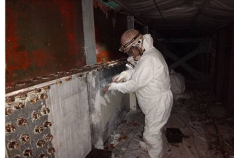
有害物質含有既存塗膜 掻き落とし作業状況② 電動ファン付き呼吸用保護具装着
