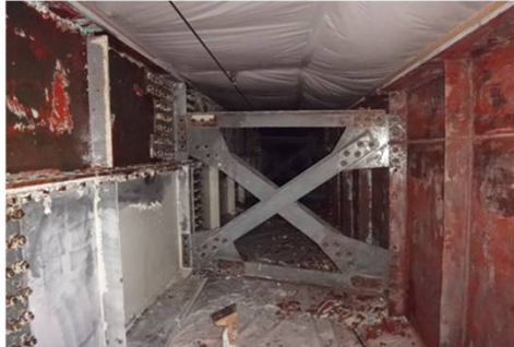
有害物質含有既存塗膜 掻き落とし作業状況①
