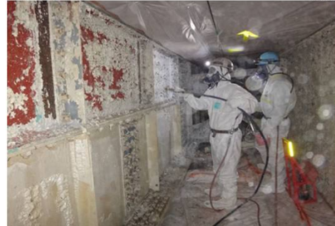
水系塗膜剥離剤 スプレー塗付作業状況 エアラインマスク装着
